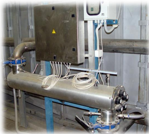
Рисунок 1.24 – Пример исполнения ультрафиолетового обеззараживателя в производственных условиях
