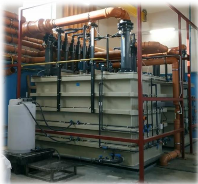
Рисунок 1.28 – Пример исполнения системы обеззараживания жидких сред хлор содержащими реагентами
